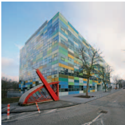
Das markante Gebäude des Zentrums für Bio-Medizin an der Universitätsstraße.
