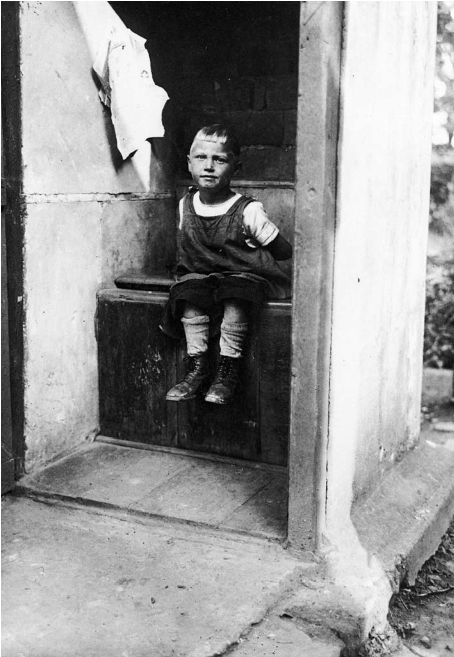
Das berühmte „Plumpsklo“ in der Kolonie. Das Plumpsklo ist eine Toilette ohne Wasserspülung. Der Kot samt Urin fällt in einen Kasten oder in eine Grube und verbleibt dort, bis die Grube bzw. der Kasten gefüllt ist und der Inhalt entsorgt wird.
